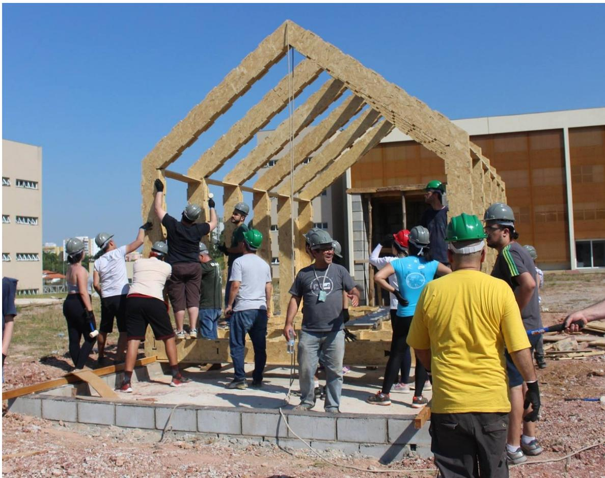
Essa estrutura de madeira, uma vez erguida, foi coberta com a sua proteção de telhas de plástico, e foram colocados os últimos elementos necessários, como portas, janelas, e instalação elétrica. Essa fase foi feita em conjunto por voluntários e a empreiteira que fez a base de alvenaria.
